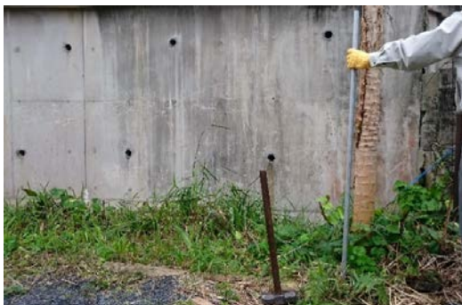
②1枚目のいのしし柵を支柱に結束線などで固定する
