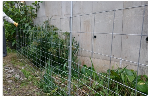
⑤支柱打ち込みと、いのしし柵の固定の繰り返し
