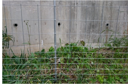
⑤支柱打ち込みと、いのしし柵の固定の繰り返し
