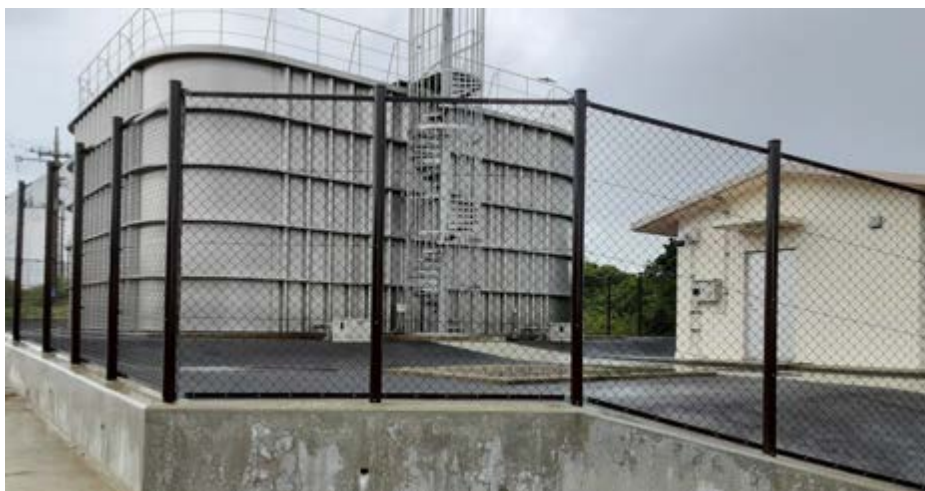
TLIRフェンス 錆びない沖縄柵めっき後塗装(ダークブラウン) 粟国水道施設土木工事(調整池工事)
