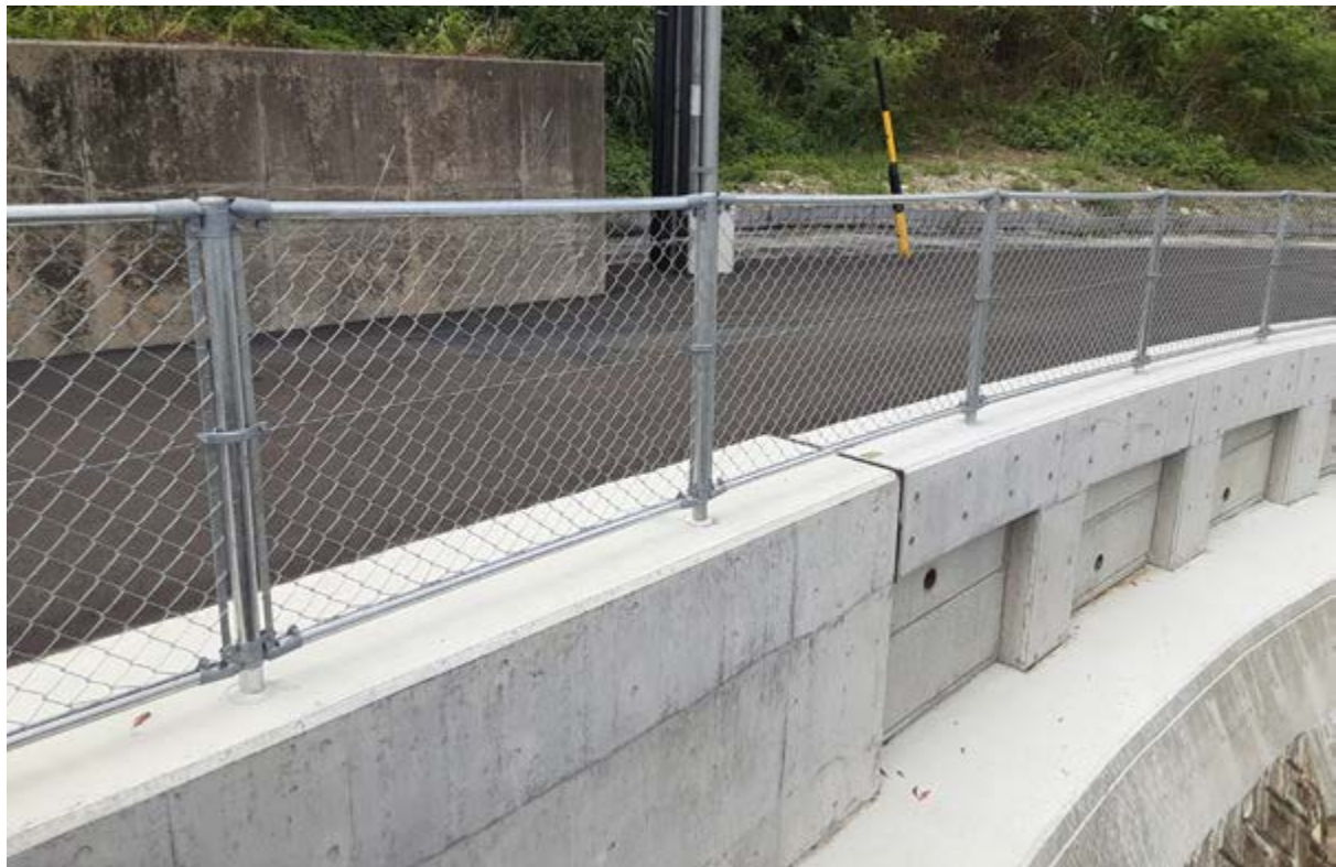
TCフェンス 南風原中央街路改良工事
