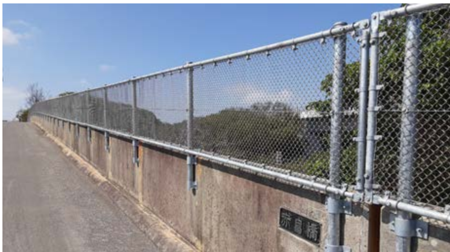
TPIRフェンス 錆びない沖縄柵(無色透明) 赤島橋防護柵取替工事
