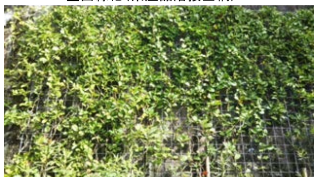
壁面緑化(県産品溶接金網)
