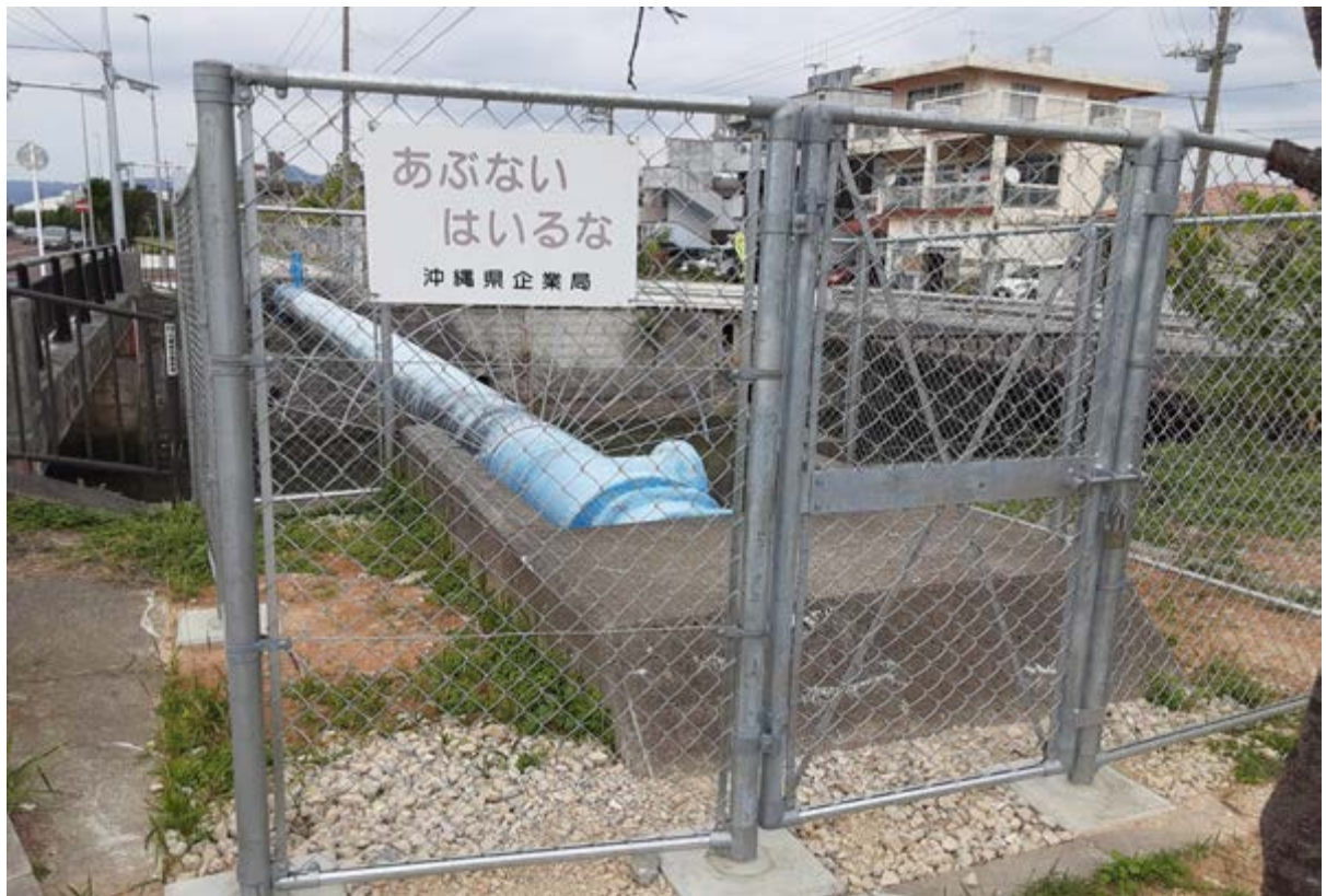
TCIRフェンス 昭和橋水管橋フェンス取替工事
