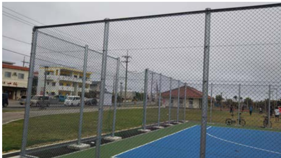
TLフェンス 真栄里公園バスケットコート・フェンス改築工事(R3-1)
