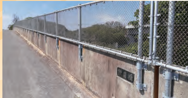
赤島橋防護柵取替工事
