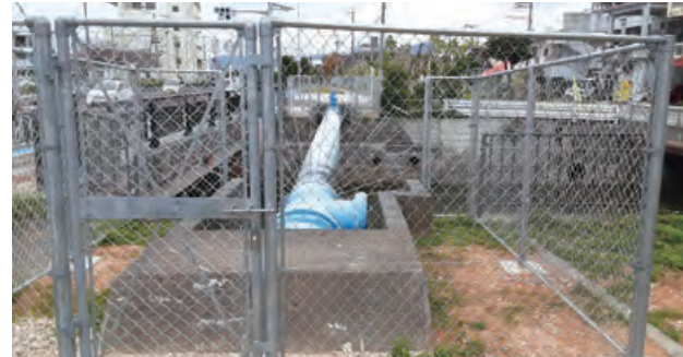
昭和橋水管橋フェンス取替工事
