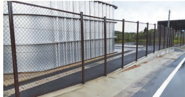
栗国水道施設土木工事 調整池工事
